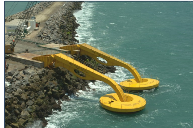
Protótipo da usina de ondas de Pecém (CE)
